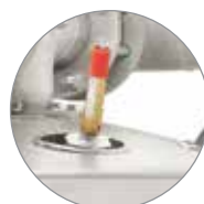
Предохранительные клапаны резервуара
